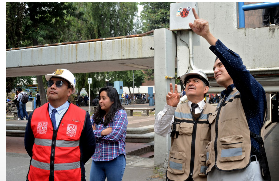
Brigada de estructuras
